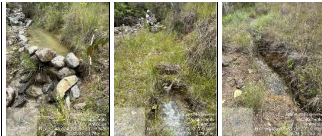
Fotografías 5 a 7. Captación y conducción por canal en tierra presuntamente por Aurelio Trujillo
