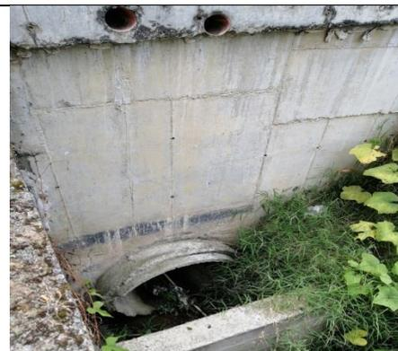
Imagen No.4 Obra transversal de diámetro 40" por donde continua la fuente de agua que se mezcla con las aguas residuales de la porqueriza más aguas lluvias
