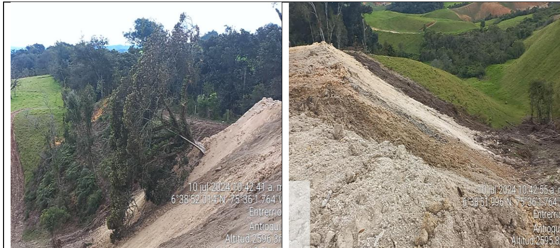
Ilustraciones 15 y 16: Detalle de los depósitos de material extraído sobre nacimientos de agua dentro del predio El Filo Vereda El Filo- municipio de Entrerríos.
