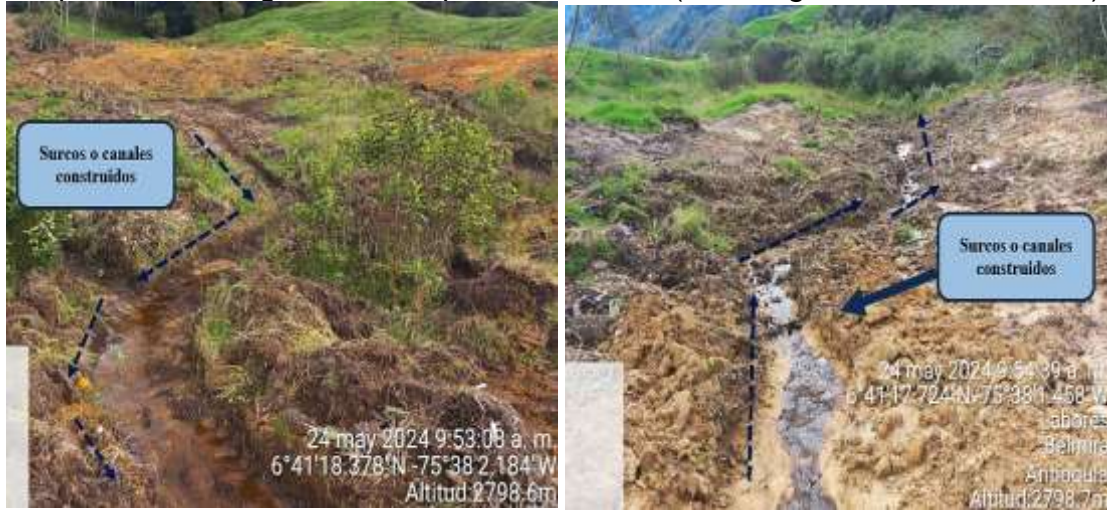
Ilustraciones 6 y 7: Construcción de canales o surcos para drenar el agua en el predio de matrícula 029-0025011, sector la candelaria, Corregimiento de Labores- municipio de Belmira-- Fuente Google Earth
