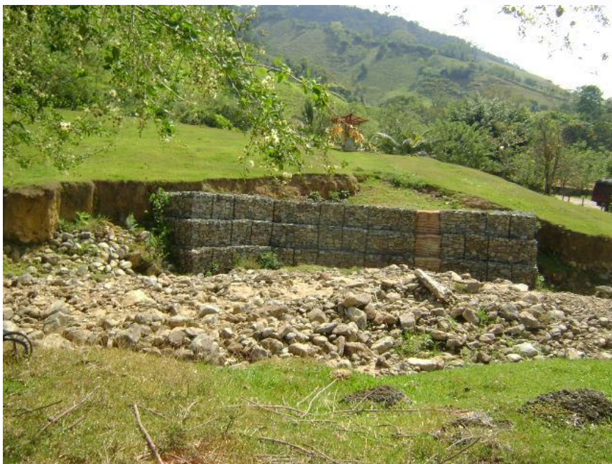
Muro en gaviones. Quebrada La Betulia parte baja
