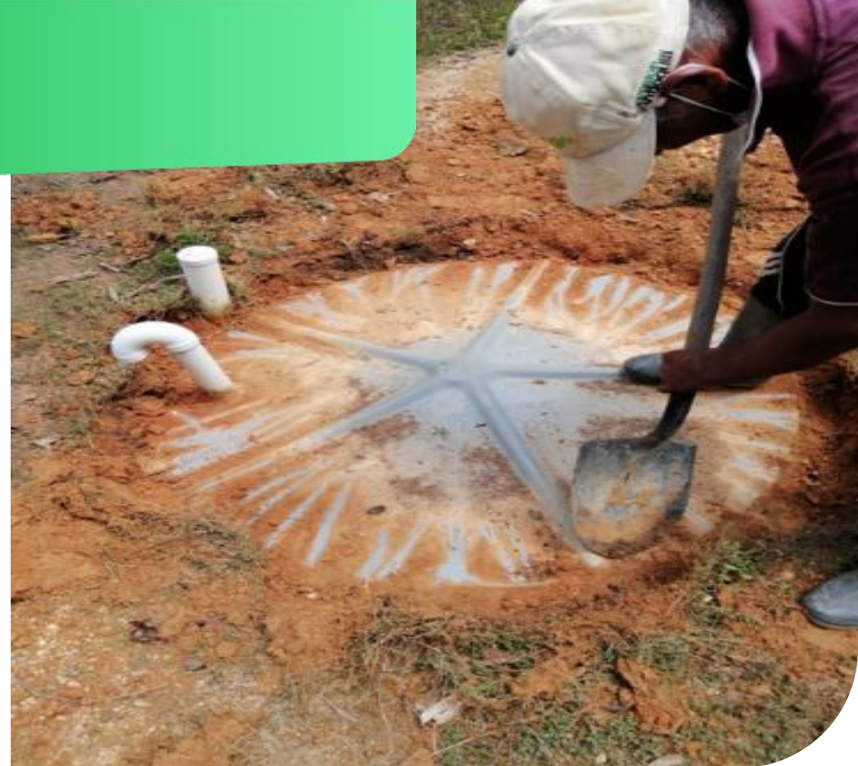
Instalación tanques sépticos
