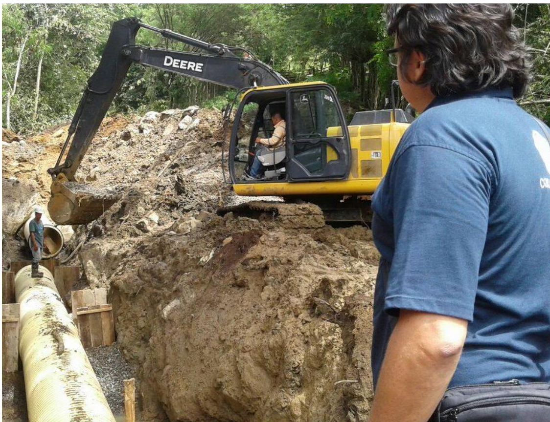
Visita construcción PTAR
