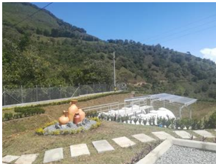
Fotografía. PTAR Corregimiento Laureles, municipio Santa Fe de Antioquia
