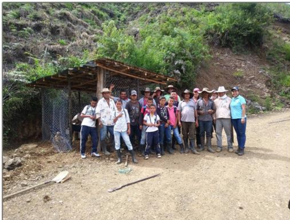
Construcción de caseta de reciclable. Ituango, vereda La Florida
