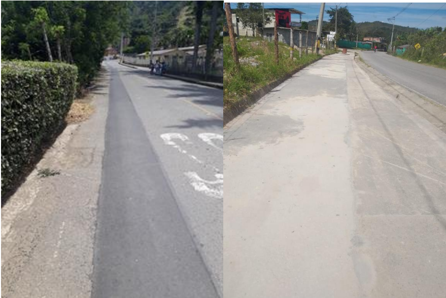
Fotografía. Colectores construidos en los municipios de Amalfi y Ciudad Bolívar
