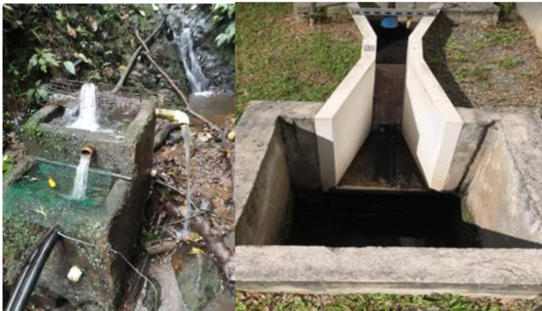
Control y seguimiento a captación de agua y control y seguimiento a vertimiento de agua residual
