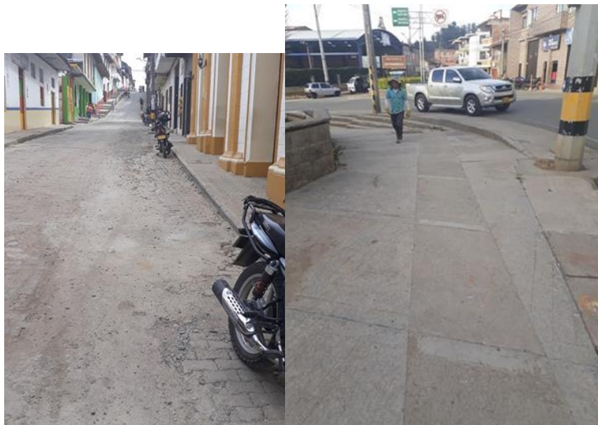
Fotografía. Construcción de los colectores en los municipios de Támesis y Entreríos
