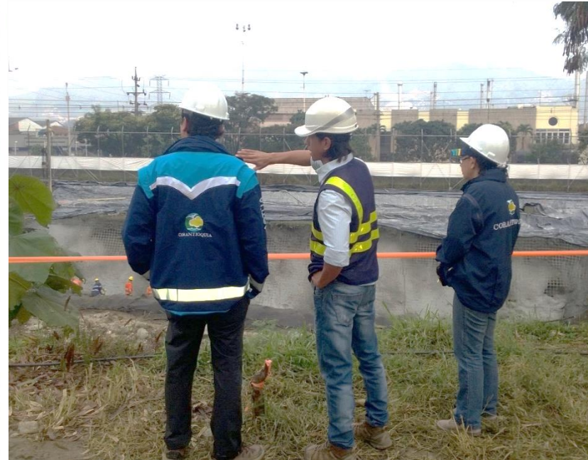
Revisión de obras
