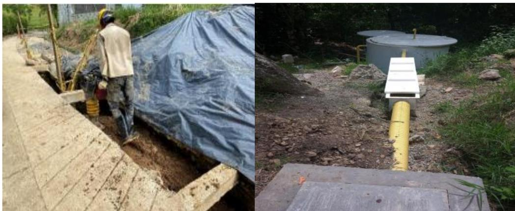
Fotografía Construcción sistema de colectores y Sistema de Tratamiento de Aguas Residuales para la vereda La Amalia
