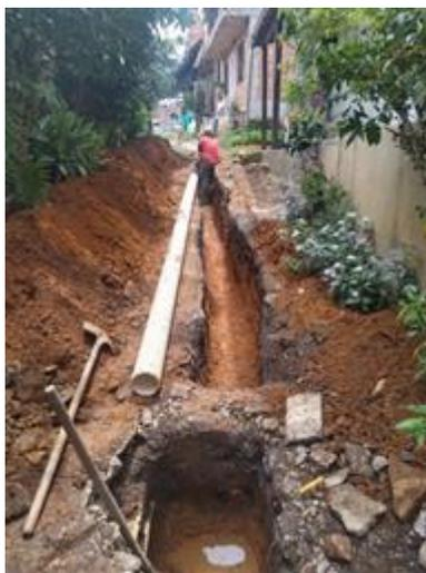
Fotografía. Construcción colector Zarzal-Curazao
