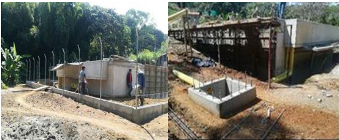
Fotos. Construcción PTAR sector La Payanca, municipio de Valparaíso
