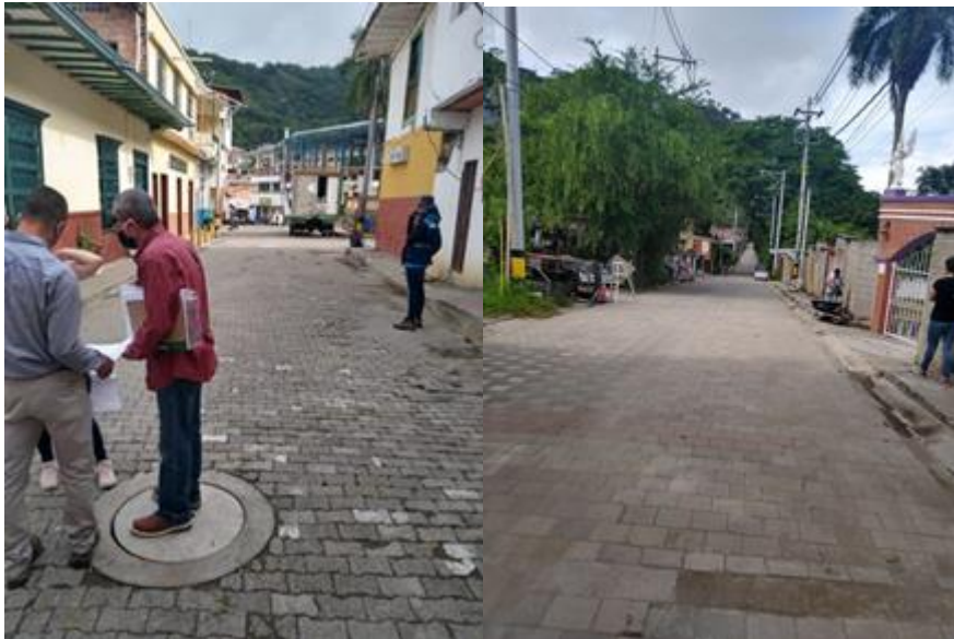
Fotos. Colector sur construido, municipio de Liborina
