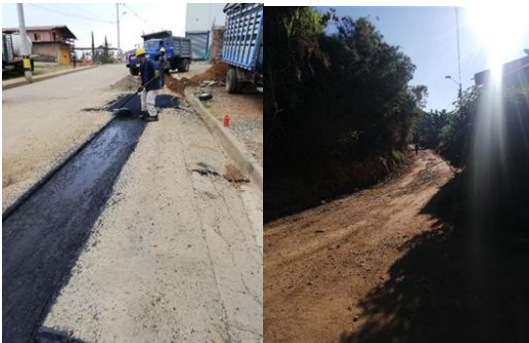
Fotos. Construcción del colector, municipio de Concordia
