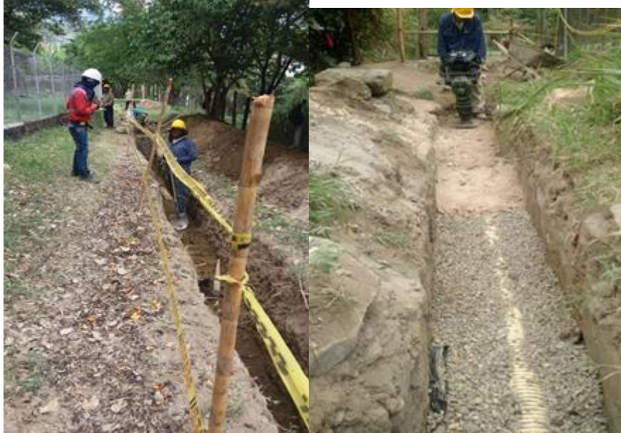
Fotos. Construcción colector vereda Zarzal-Curazao, municipio de Copacabana
