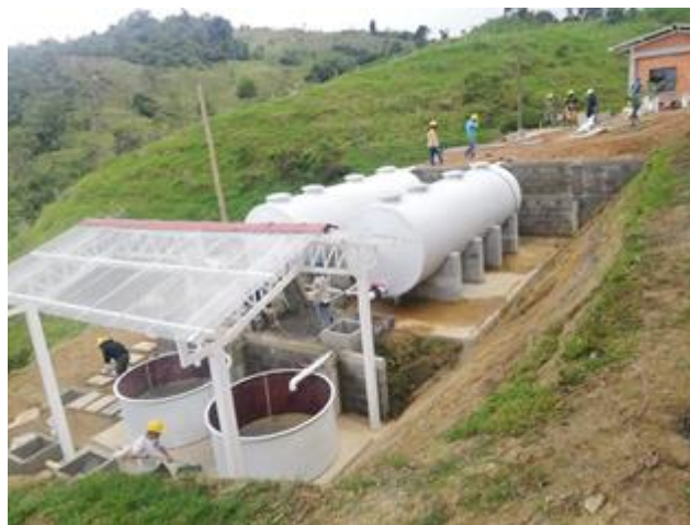
Foto. Construcción PTAR, Corregimiento Buenavista, municipio de Toledo
