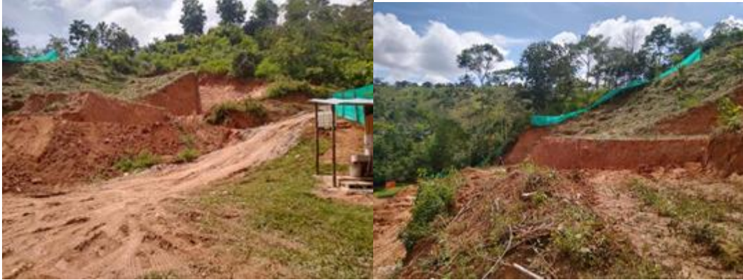
Fotos. Excavaciones construcción de la PTAR sector Palo Cabildo, municipio de Remedios
