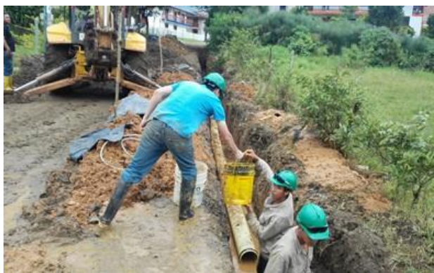
Fotografía. Construcción de colectores y PTAR, municipio de Jardín
