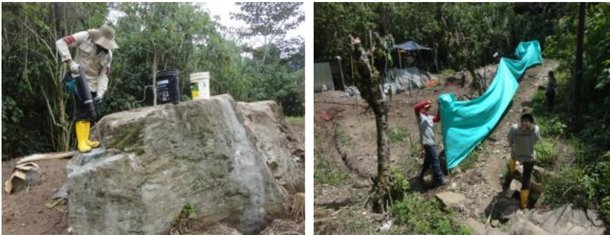
Fotografía. Construcción PTAR, municipio de Titiribí
