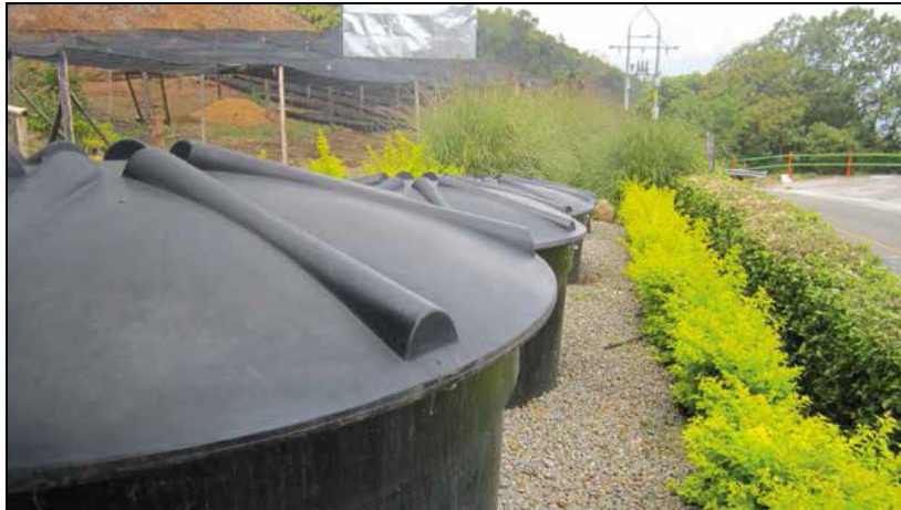
Foto. Sistema Modular de Tratamiento Anaerobios de aguas mieles SMTA Fredonia Antioquia.
