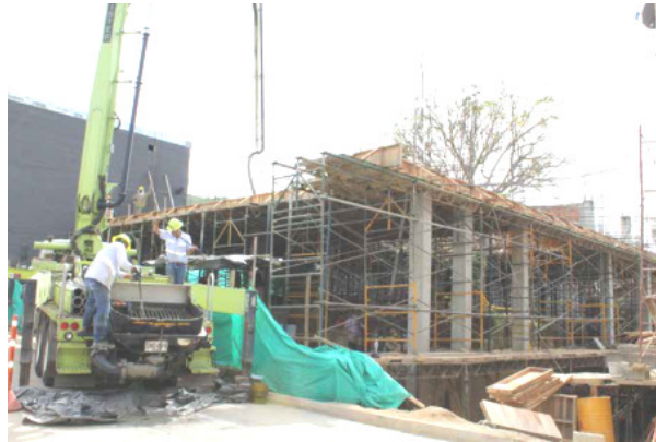
Foto. Avances construcción sede Vegachí
