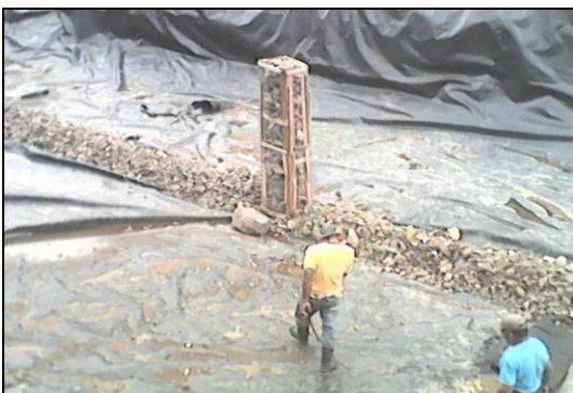
Fotos. Relleno sanitario de Buriticá (obras de adecuación del terreno e instalación de 600 m 2 de geomembrana HDPE de 40 mils)
