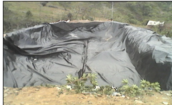
Fotos. Relleno sanitario de Buriticá (obras de adecuación del terreno e instalación de 600 m 2 de geomembrana HDPE de 40 mils)
