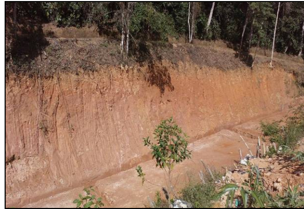
Fotos. Relleno sanitario de Maceo (obras de adecuación del terreno previo a la instalación de 1500 m 2 de geomembrana HDPE de 40 mils)
