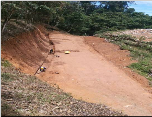
Fotos. Relleno sanitario de Maceo (obras de adecuación del terreno previo a la instalación de 1500 m 2 de geomembrana HDPE de 40 mils)
