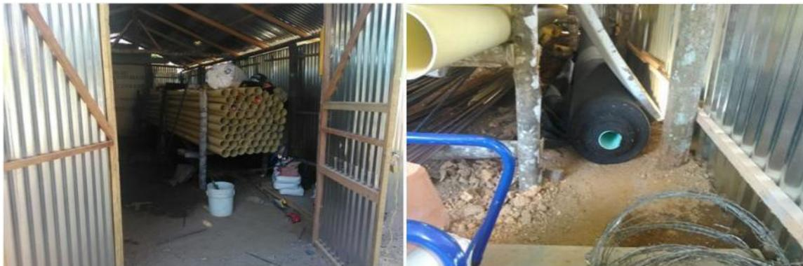
Suministros de materiales (geomembrana, geotextil y tubería PVC-S diferentes diámetros)
