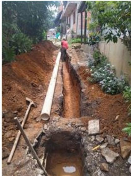
Foto. Construcción colector Zarzal-Curazao
