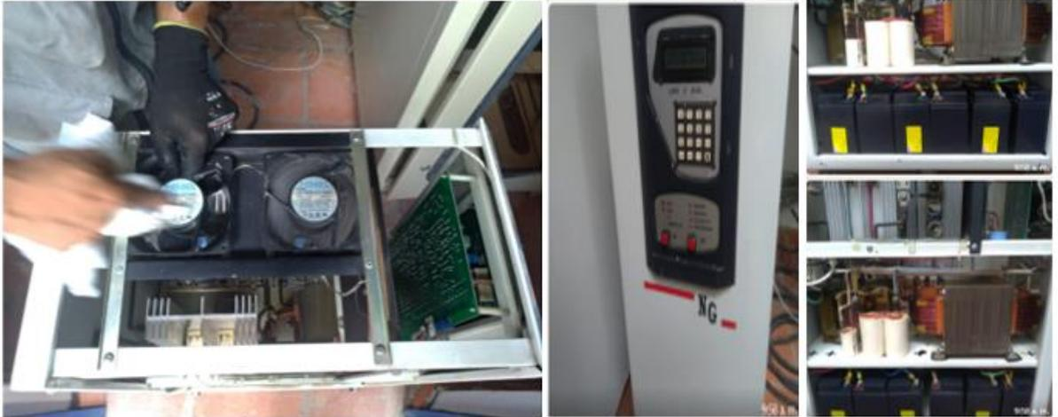
**MANTENIMIENTO DE SUBESTACIÓN Y UPS:** se realiza el mantenimiento a los tableros de la subestación y se instalan tableros para separación de circuitos.
