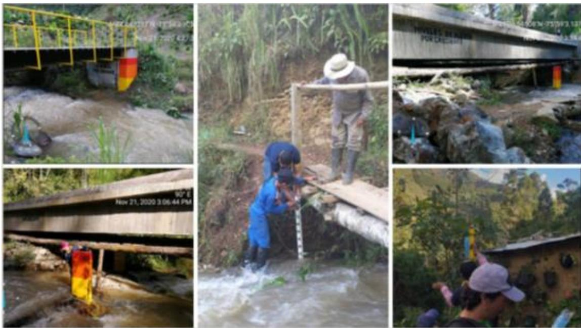
Foto. Pintura de limnímetros e instalación de regleta y pluviómetros vereda La García – sector La Escuela (Caicedo)
