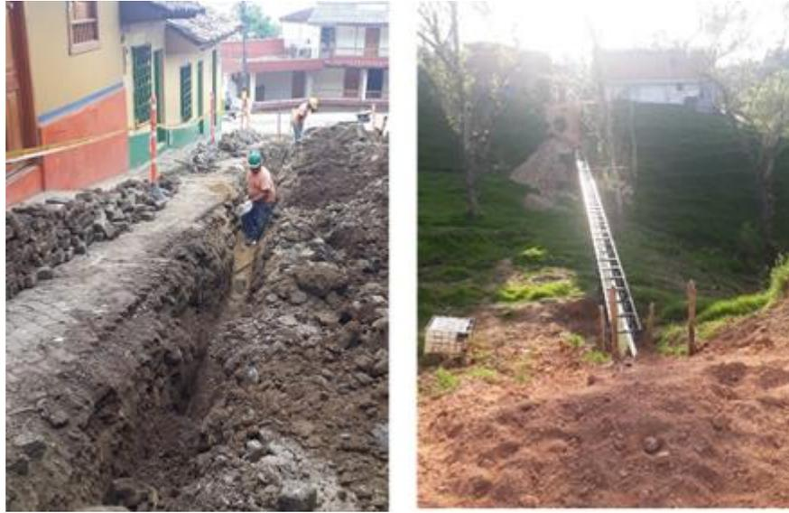
Fotografía. Construcción de los colectores en los municipios de Támesis y Entreríos
