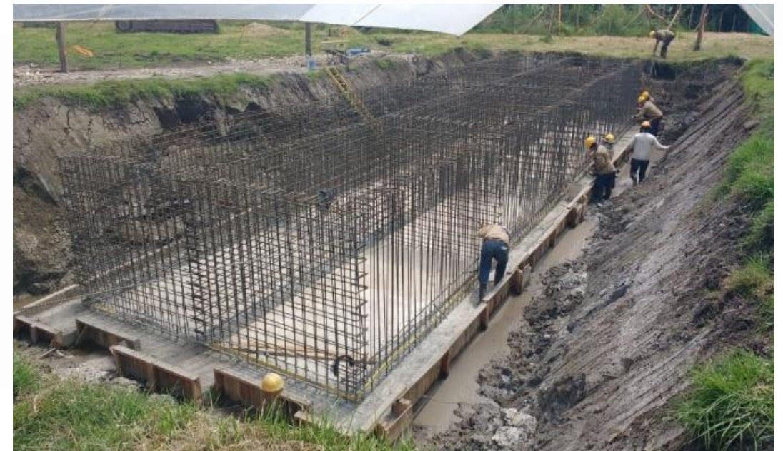
Construcción de colectores y PTAR, Corregimiento Ovejas, municipio de San Pedro
