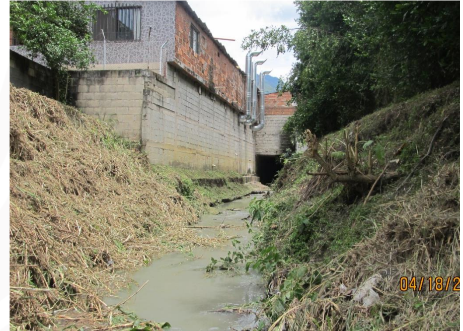
Limpieza de quebradas
