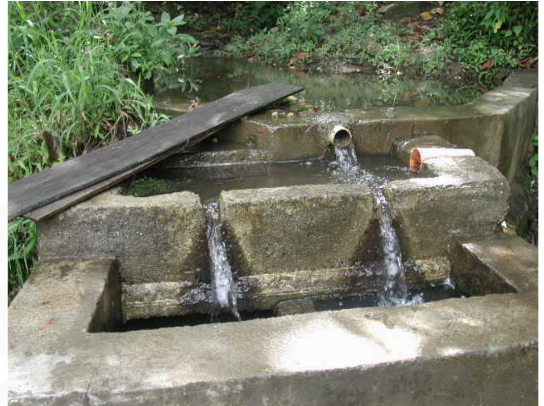
Obra de control y reparto
