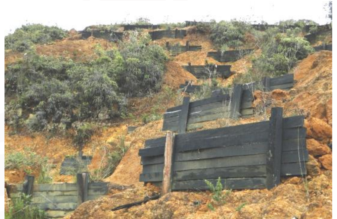
Trinchos para la recuperación de suelos en occidente antioqueño
