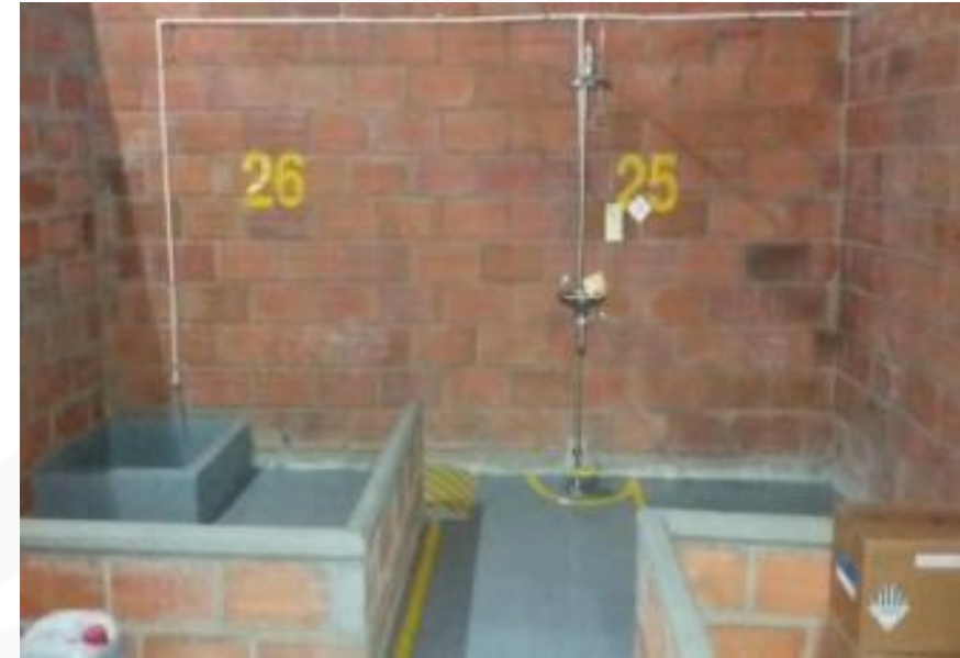
punto de clasificación y separación adecuada de residuos sólidos
