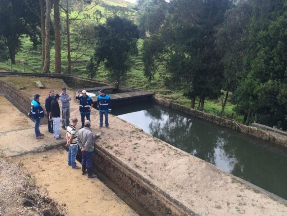
Visita Pequeña Central Hidroeléctrica San José de la Montaña
