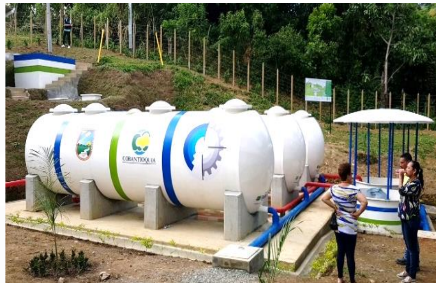
Construcción de colectores y PTAR, Corregimiento Damasco, municipio de Santa Bárbara
